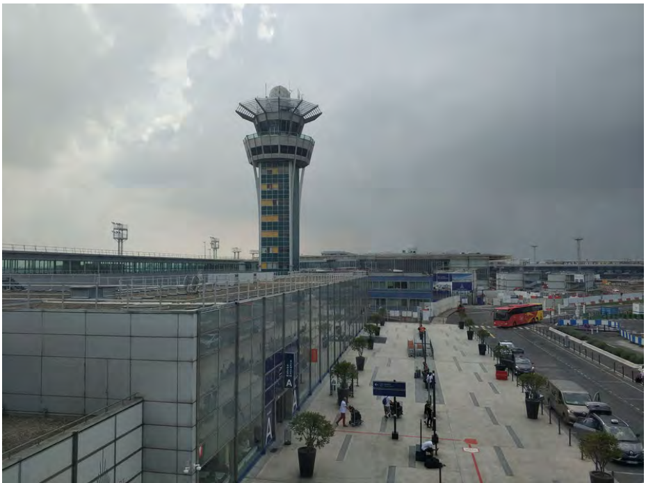
La tour de contrôle d'Orly, vue depuis la station Orlyval
