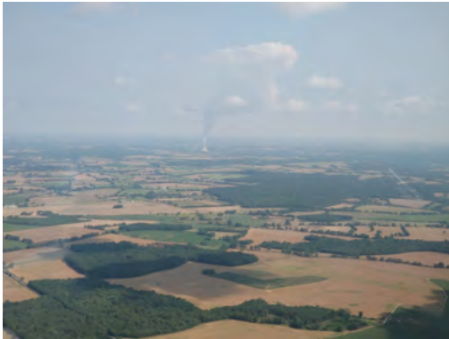
Centrale nucléaire de Civeaux
